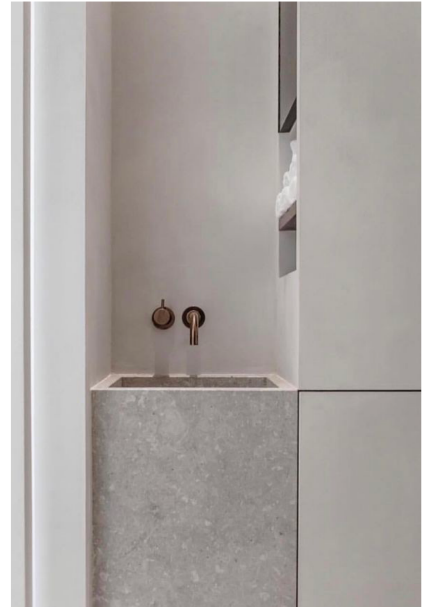
Na stěnách celoplošná stěrka
